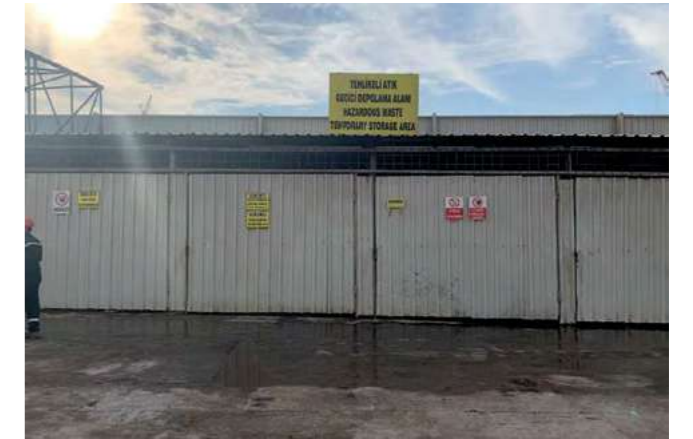
Tehlikeli atık geçici depolama alanı
