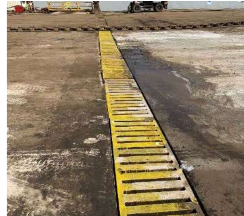
Drenaj hattı ve drenaj toplama alanı Kaynak: Dörtel AB Saha Denetim Raporu (19.9.2022)
