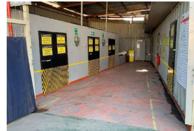
Tehlikeli atık geçici depolama alanının içerden görünümü
